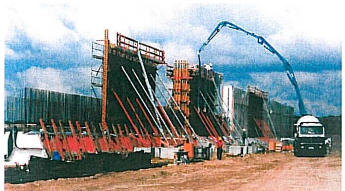
Blockweises Betonieren beim Bau der Schleuse Magdeburg-Rothensee
