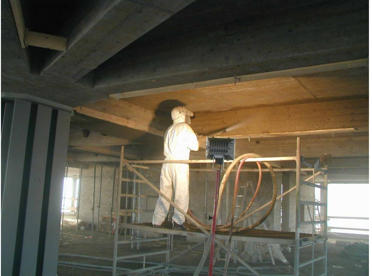
Bild 1: qualifiziertes und erfahrenes Personal sichert werthaltige Betoninstandsetzung
