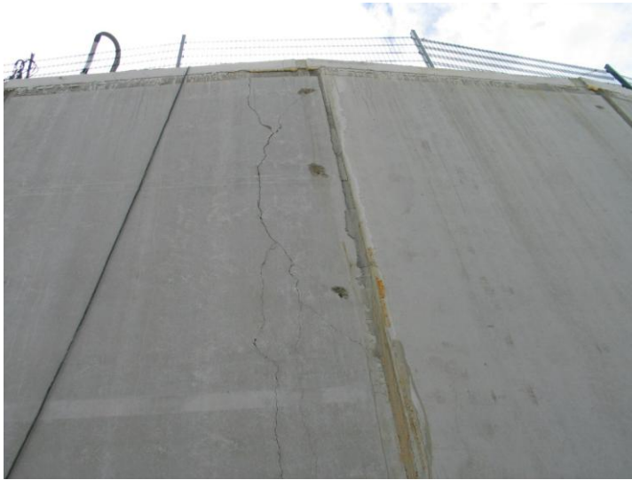
Abb.2: zerstörte Elementwand
